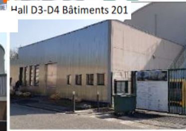
Hall D3-D4 Bâtiments 201
